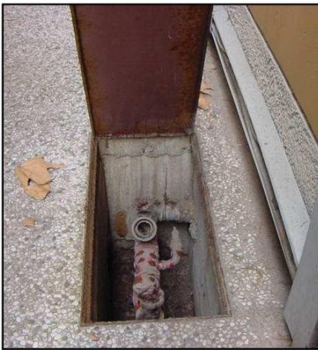
Figura 14: Attacco motopompa VVF
