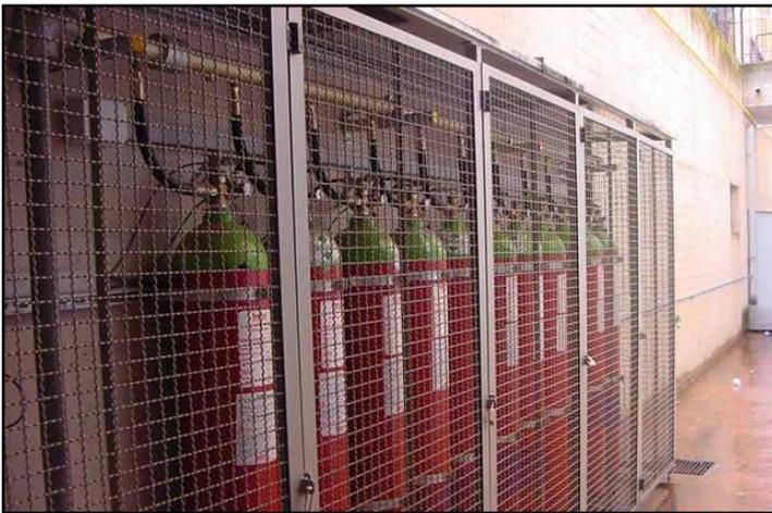
Figura 22: Piano Interrato – Gruppo bombole impianto di spegnimento automatico
